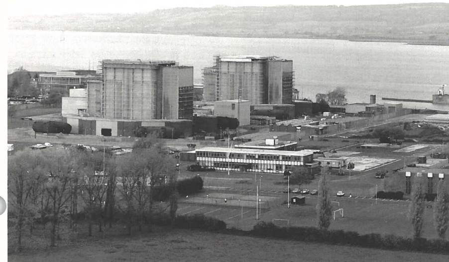
АЭС Беркли после 2 стадии снятия с эксплуатации (со снижением уровня крыши реакторного отделения)
