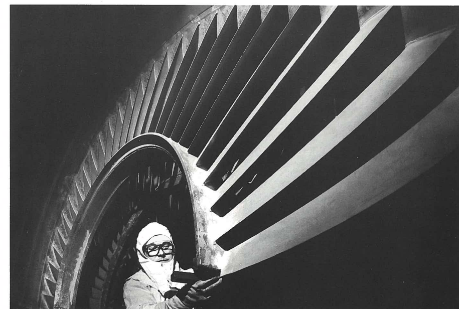
Инспекция лопаток турбины на АЭС Гранд Галф
