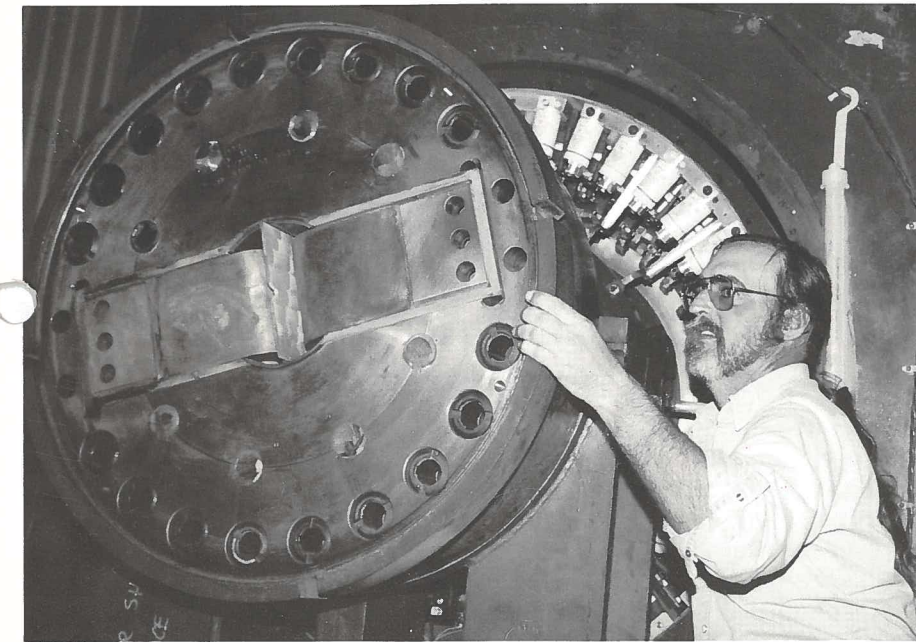
Инспекция электрооборудования на АЭС "Южнотехасский проект"
