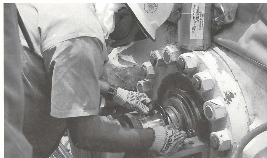
Ремонт валопровода на АЭС "Южнотехасский проект"
