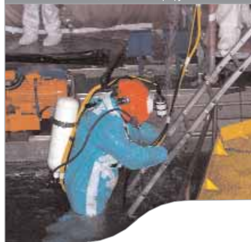
Подводная дезактивация в бассейне перегрузки
