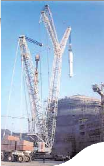
Монтаж тяжеловесного оборудования
