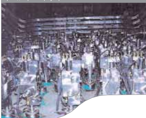
Приводы органов регулирования СУЗ
