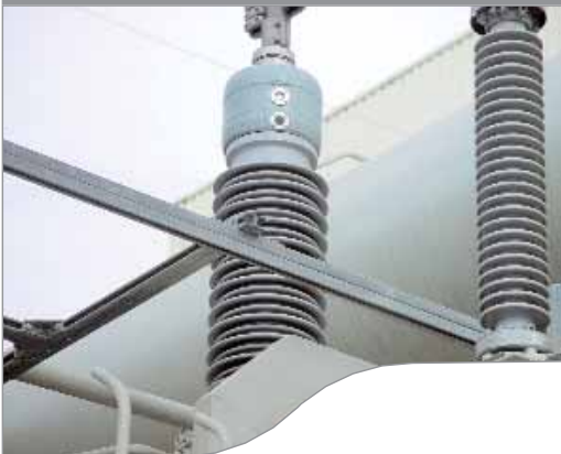
Ввод трансформатора после покрытия новым изоляционным материалом
