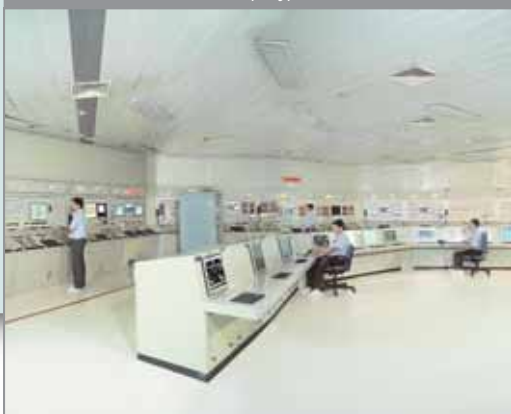
БЦУ 3-го и 4-го блоков АЭС Тарapur
